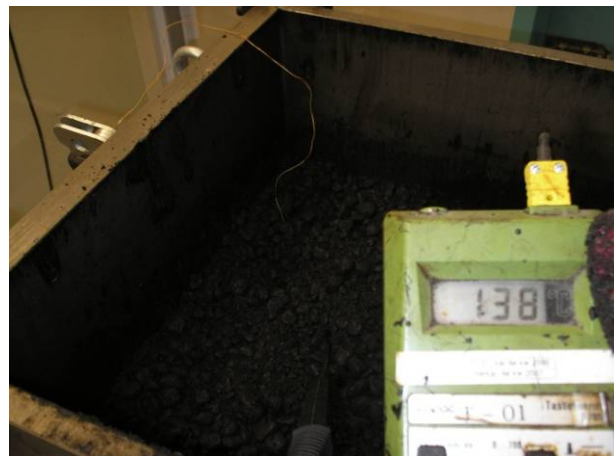
Figuur 3.12: Temperatuur meten voor verdichten
